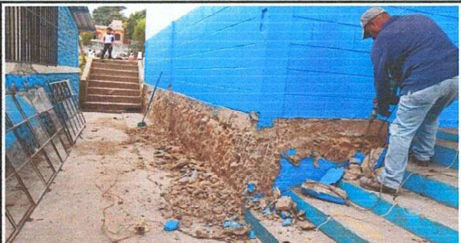
Foto 4: Reparacion de repello exterior modulo aulas de parvulos
