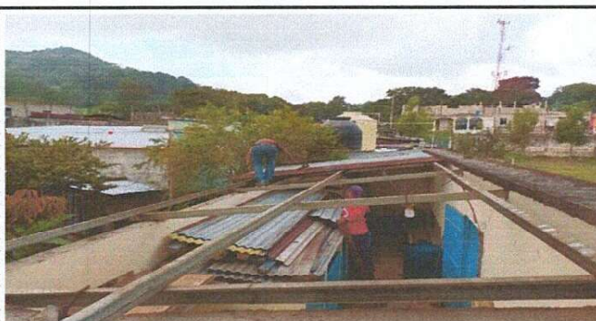
Foto 5: Cambio de cubierta de lamina modulo de sanitarios alumnos.
