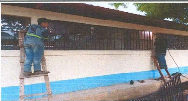
Foto 3: Sustitucion de ventanas y balcones de estructura de metal modulo 2
