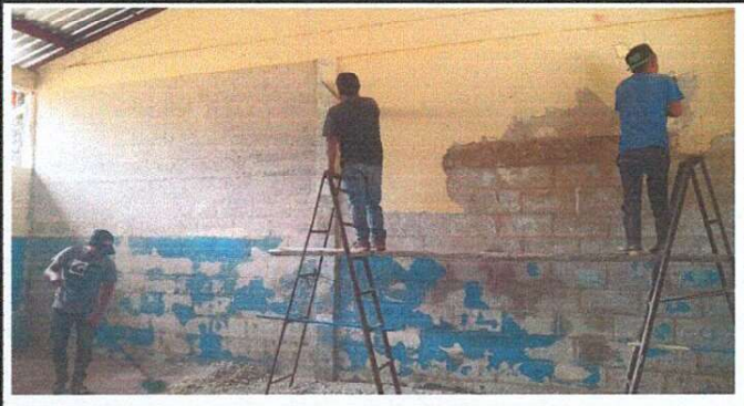
Foto 2: Reparacion de repello y cernido aulas de parvulos
