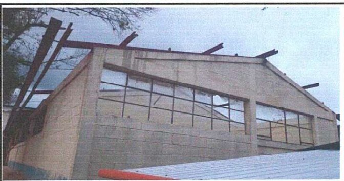
Foto 6: Mantenimiento de soporte de estructura de metal modulo 2
