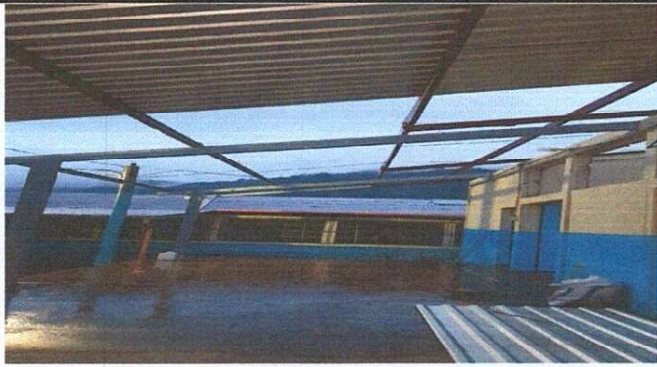
Foto1: Cambio de cubierta de lamina modulo 2
